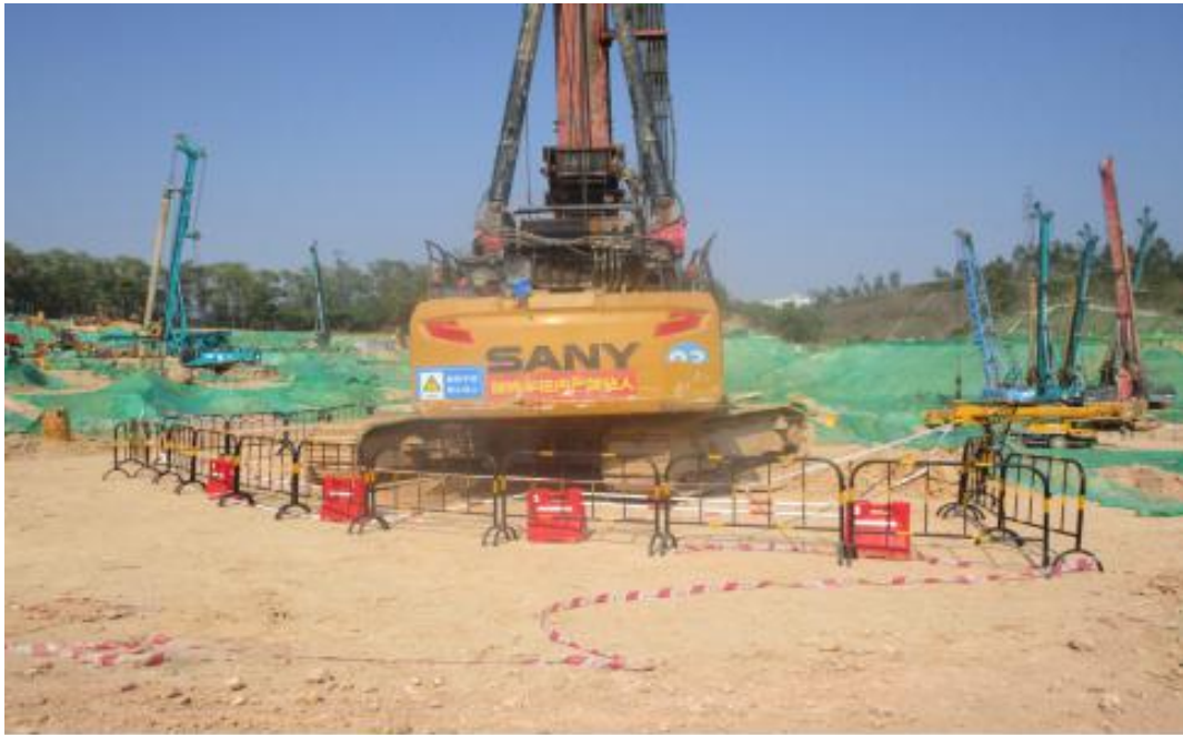
图 7 旋挖钻机作业面警戒措施
