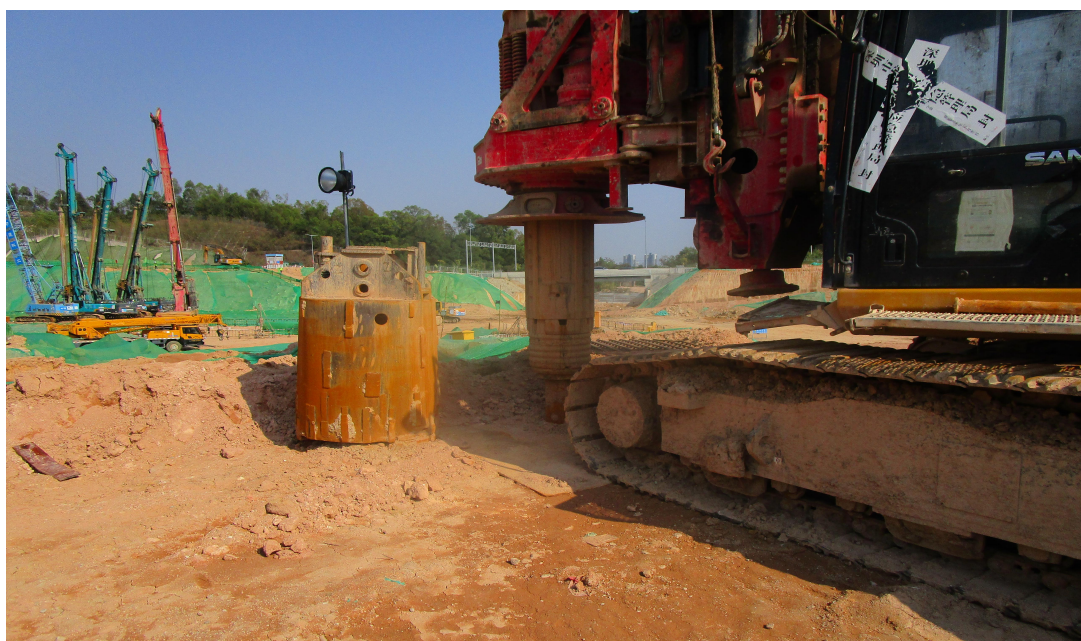
图 6 旋挖钻机停放情况
