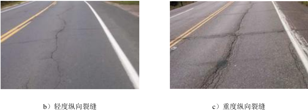
图A. 3 纵向裂缝病害分级图示
