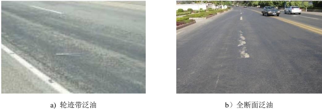
图A.9 泛油病害图示
