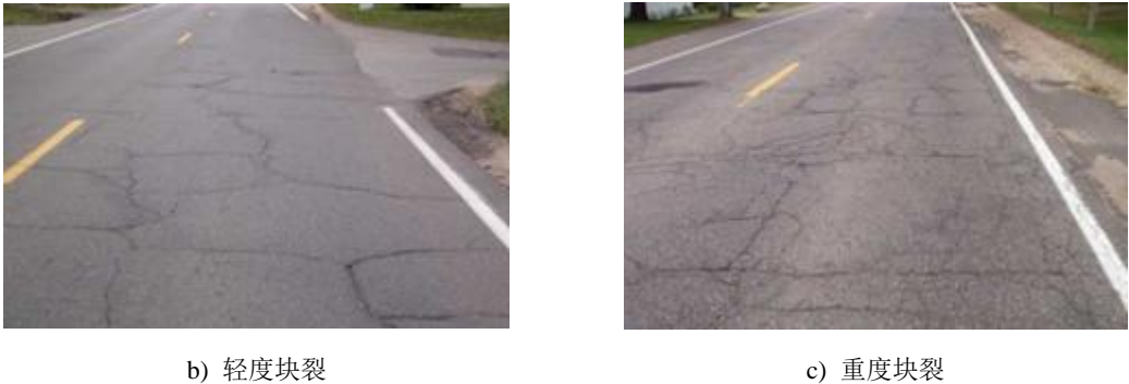
图A. 2 块状裂缝病害分级图示
