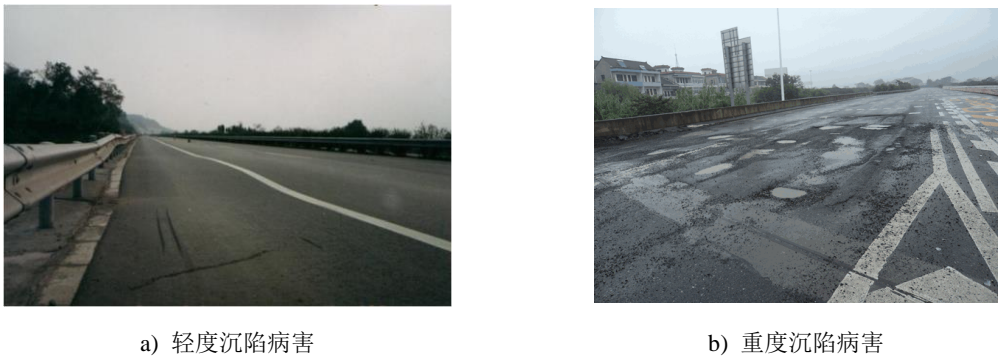
图A.7 沉陷病害分级图示
