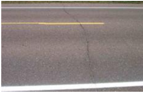
b) 轻度横向裂缝
